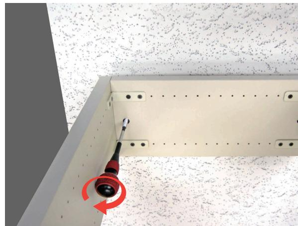
棚を設置しプラスドライバーで金具Aを回し、天井当て板が天井に付くまで締め込みます。このとき棚全体がしっかりと固定されるまで締め込まれているか確認してください。
