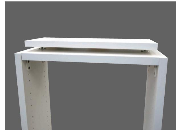
天井当て板を**受穴に合わせて**金具Aの上に置き、高さを設置する天井よりやや低く調整します。
